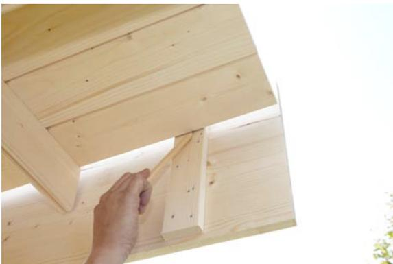
Nun wird die untere Dachkante an den Querriegeln der Blende angezeichnet.
