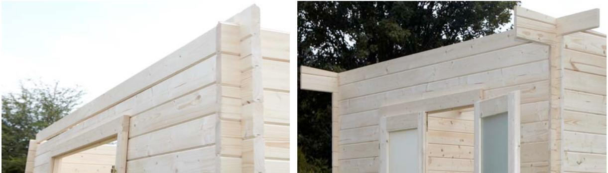
Mit dem Aufbau der letzten Wandbohlen werden auch die mittleren, querlaufenden Dachbalken eingesetzt. Wenn Sie alles richtig gemacht haben, erhalten Sie ein Montagebild wie auf der ...
