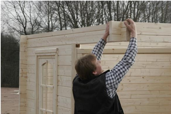
Nach dem Einbau des Türrahmens können abschließend die letzten längsten oberen Wandbohlen aufgelegt werden. Sie bilden den Abschluss der Wände und die überstehende Ecke im Türbereich.
