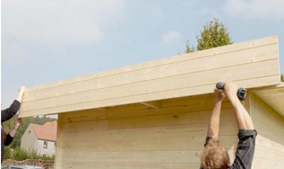
Die erste Seitenblende wird angehalten. Am höchsten **Dachpunkt etwa 8-10 cm oberhalb der Dachoberfläche, Vorderkante Blende bündig mit Vorderkante Dachfläche, waagrecht ausrichten !!**
