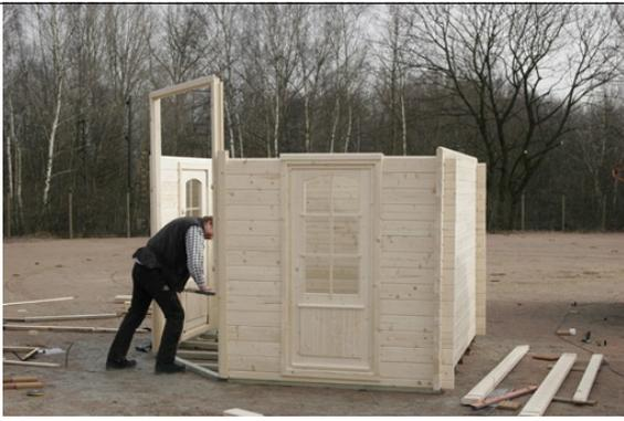
Der zusammengesetzte Türrahmen kann jetzt von oben auf die Türstöcke geschoben werden
