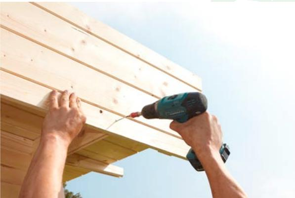
Auch die Blende an der Vorderseite des Hauses braucht die gleichen Riegelein-schnitte. Hier werden bei gleicher Vorgehensweise die Riegel alle auf gleicher Höhe unterbrochen. Die Schnitthöhen ergeben sich durch das Anhalten der Vorderblende an den schon montierten Seitenblenden.
