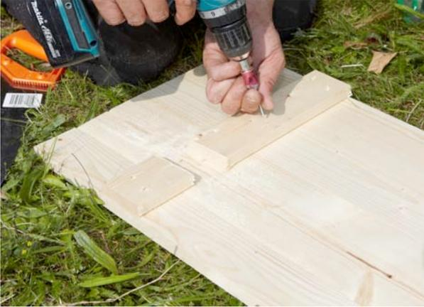
Eventuell kann es erforderlich werden, die ein oder andere **Schraube zu versetzen**, bzw. den **Querriegel** an der ein oder anderen Stelle **nach zu schrauben**, um die gesamte Blende zusätzlich zu stabilisieren.
