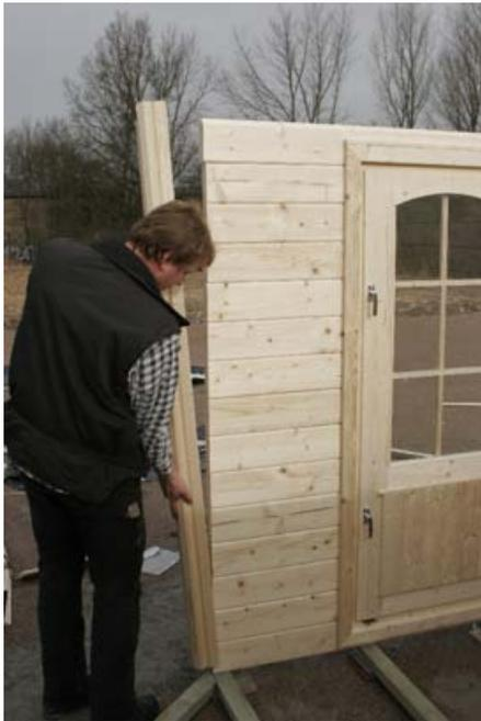
Nach dem Einbau dieser ersten durchgehenden Bohle ist es Zeit für die Türstöcke links und rechts in der Türöffnung. Diese werden mit der Ausnutzung wie die Fensterelemente auf die Bohlenenden aufgeschoben und dort verschraubt.
