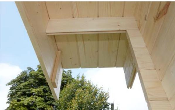
Durch die unterbrochenen Querriegel können nun die seitlichen Dachblenden direkt an der Dachkante anliegen und an den Dachbalken - enden verschraubt werden.
