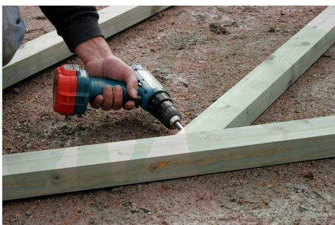
Nun die umlaufenden Lagerhölzer (Ringbalken) auslegen. Die unterste Bohlenreihe der Wände schon jetzt auflegen, und an verschiedenen Stellen schräg mit den Ringbalken verschrauben. Das macht die jetzt folgende Montage einfacher.
