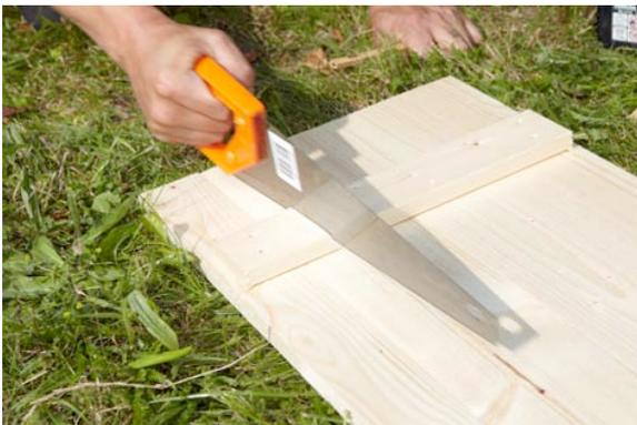
Die Querriegel werden an diesen Stellen mit einer Handsäge komplett durchtrennt.
