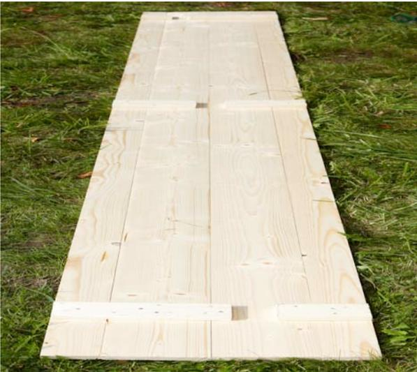
Es ergibt sich ein Bild wie links dargestellt. Die Querriegel der Seitenblenden sind **mit der Gefälleneigung des Daches unterbrochen**.
