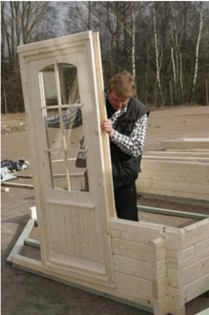
Bei etwa halber Wandhöhe werden die schon vorgefertigten Fensterelemente eingeschoben.
