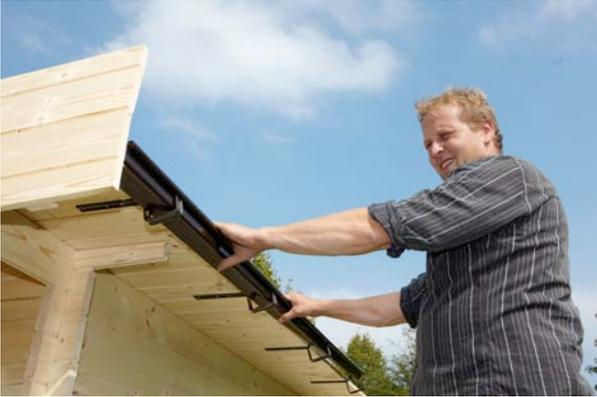
In die montierten Haken wird nun die Rinne eingelegt und durch **Herunterdrücken** der noch nach oben stehenden **Haltelaschen** fixiert. Mit den **Verbindungs-muffen, Ablaufstutzen, Fallrohr und entsprechendem Zubehör** kann nun das Wasser abgeleitet werden.
