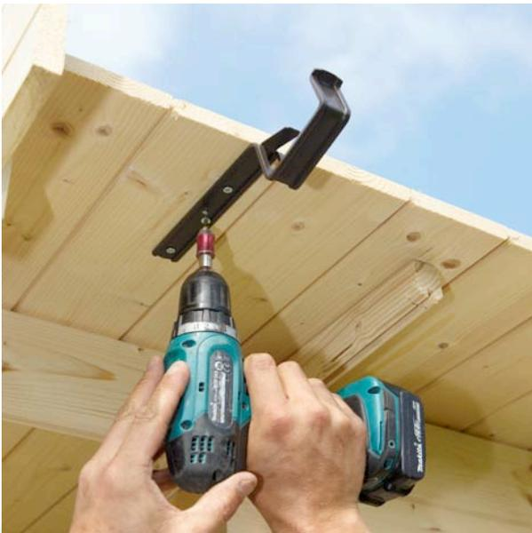
Als nächstes werden die **Rinnenhaken** an der **hinteren Dachkante des Hauses angebracht** und gleichmäßig auf die gesamte Länge des Daches verteilt.
