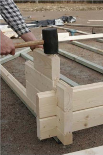
Beim Aufbau der Wände nie mit dem Hammer direkt auf die Bohlen schlagen. Benutze Sie den Hauklotz.
