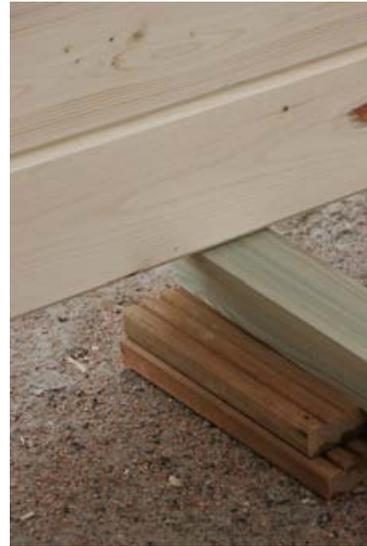
Der Grundrisszeichnung entsprechend die inneren Lagerbalken auf der Hausfläche verteilen, und mit dem Ringbalken verschrauben.
