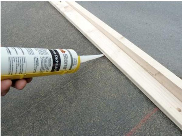
**Die Fugen sollten mit Silikon (nicht im Lieferumfang enthalten) gedichtet werden.** Die Dacheindeckung ist fertig
