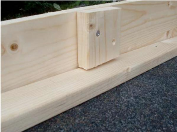
Da im vorherigen Schritt die Querriegel der Blenden etwa 5 cm unterbrochen wurden, kann nun auch die innenliegende Dach-abschlussleiste gegen die Blende geschoben und dort verschraubt werden
