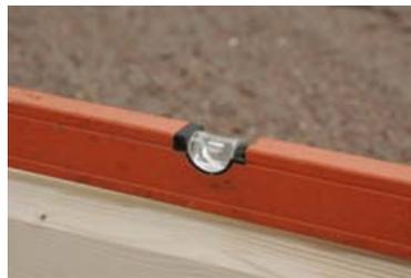
Das Haus wird durch Unterklotzen in Waage gestellt. Verwenden Sie witterungsbeständige Holzreste vom Händler, z.B Bangirai.
